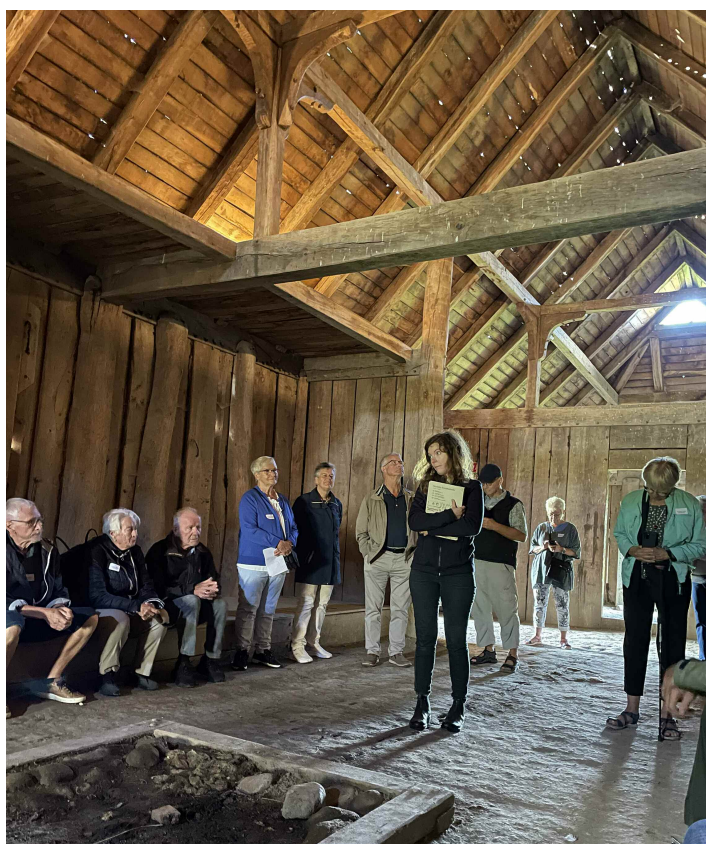
Langhuset på Fyrkat er bygget i egetræ, og det er 28,40 meter langt, 7,40 meter bredt og 7,50 meter højt. Det er rekonstrueret efter de 16 langhuse, der lå inden for volden. Langhuset bruges bl.a. til Fyrkatspillene. Formidlingsinspektør, cand. mag. Mette Lykkegård-Maes - i midten - forklarer deltagerne i sommerudflugten om langhusene på Fyrkat og på de øvrige ringborge. Foto: Lisbeth Roth.
